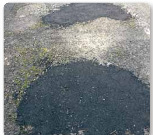
観月橋団地 周辺道路補修
