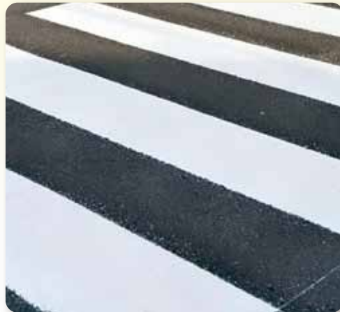
日野学区 横断歩道補修
