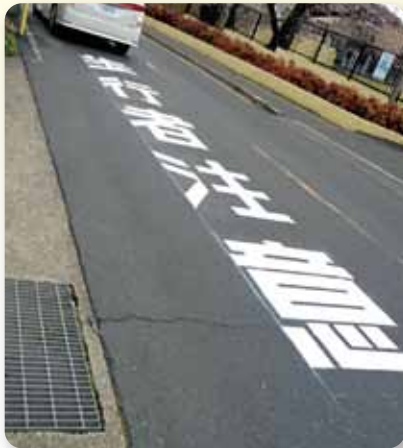
石田大山町 安全対策
