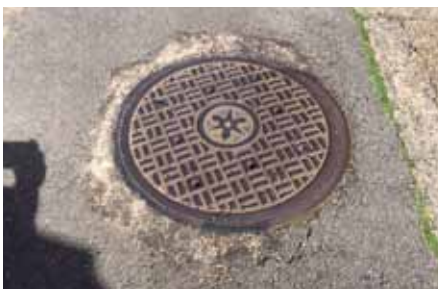
醍醐東合場町のマンホール修復
