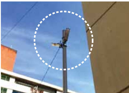
大受団地の棟間道路に市街灯を新設
