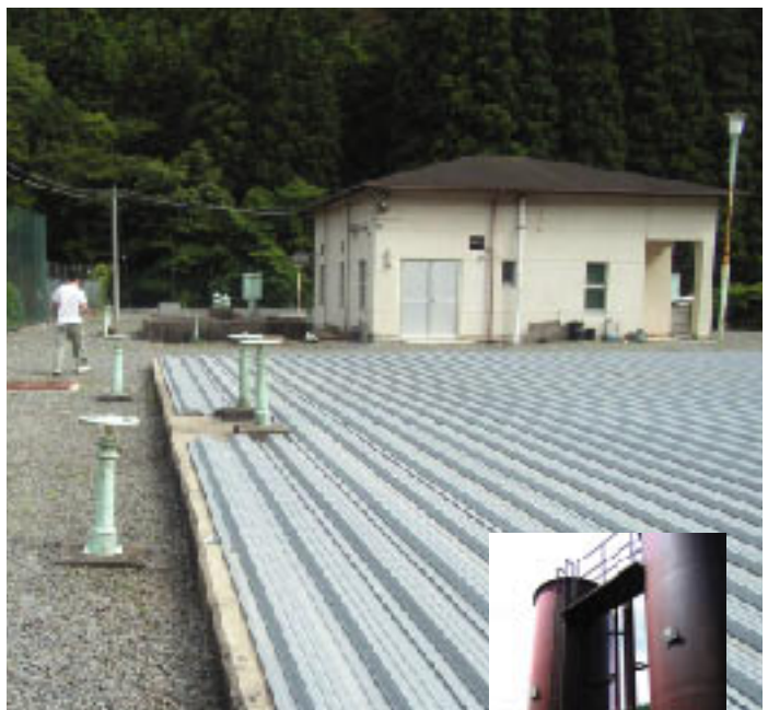
大原簡易水道第1浄水場
